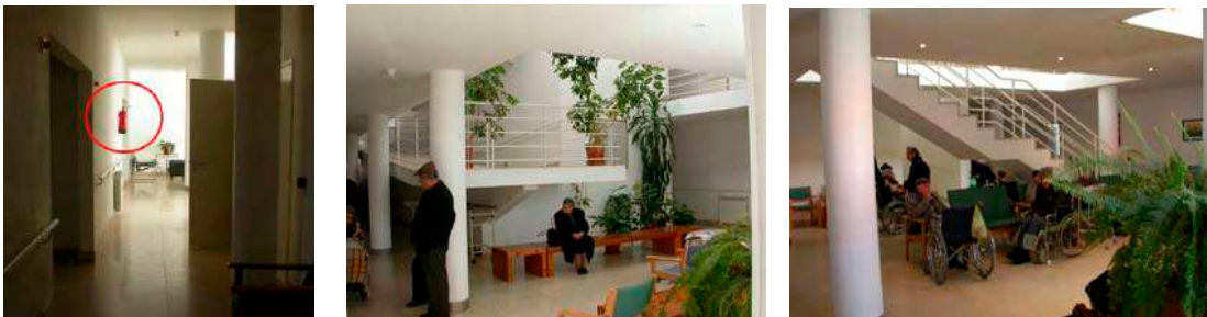
Fig. 5.24 - Obstáculos não detectáveis ao nível do solo e colocação de elementos barreira sob a rampa e sob a escada interior
