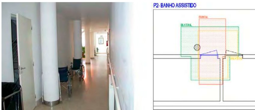
Fig. 5.39 - Dificuldade de manobra da porta do banho assistido devido ao pilar
