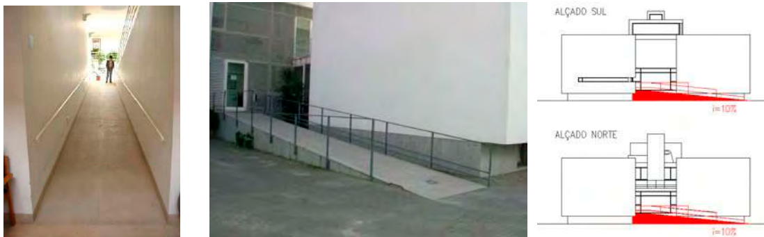
Fig. 5.37 - Rampa interior e rampas exteriores do edifício
