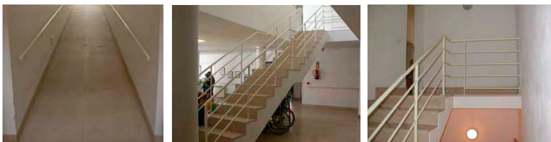
Fig. 5.17 - Corrimão da rampa interior e pormenores das escadas interiores
