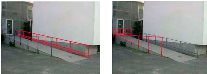
Fig. 5.32 - Corrimão e guarda da rampa exterior
