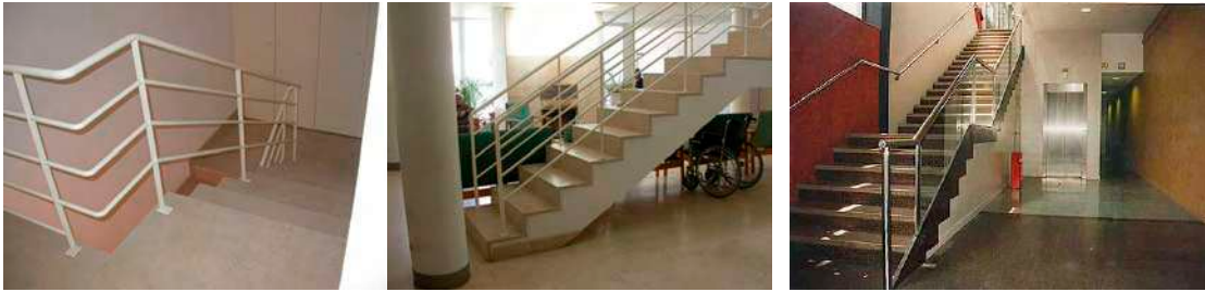
Fig. 5.25 - Imagem das escadas enclausuradas e abertas do Bloco de Acamados e exemplo de escadas acessíveis [45]
